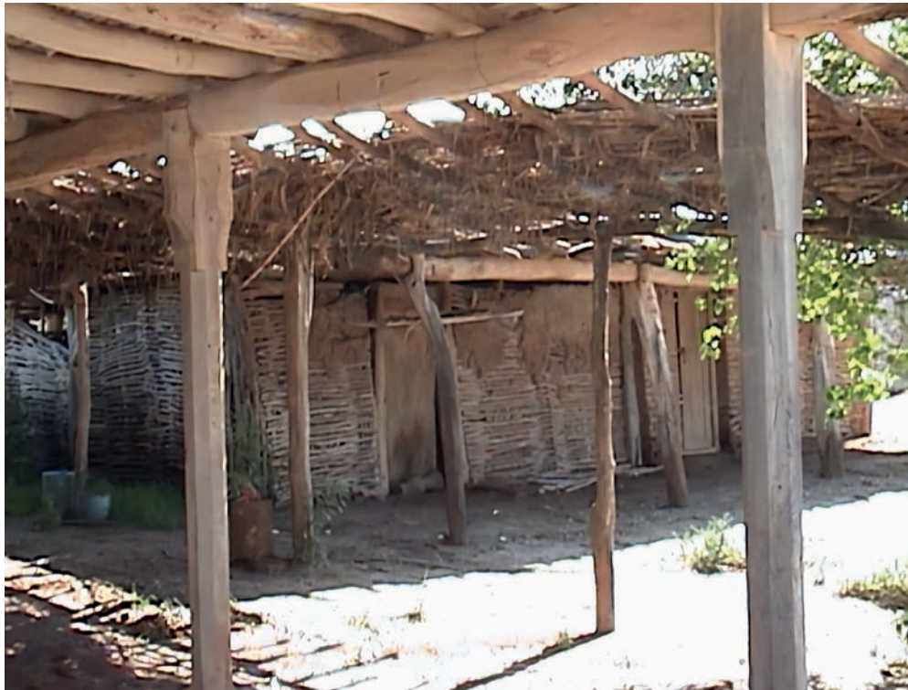
FIGURA 1. Edificación de bajareque con entramado de vara blanca y barro, ubicada en El Playón, municipio de Angostura, Sinaloa
