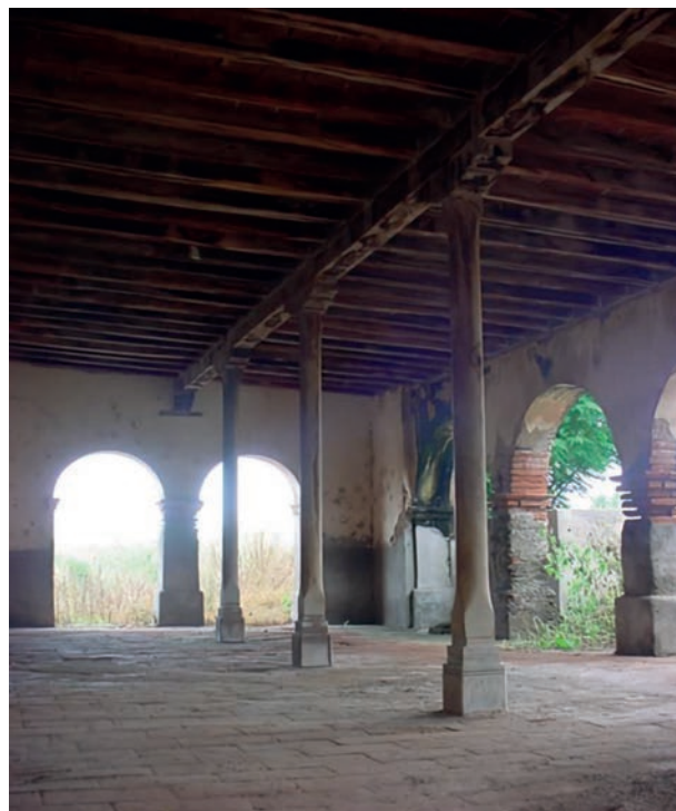
FIGURA 11. Portal con doble eje longitudinal con un eje interior de apoyos y zapatas de madera y otro eje, el exterior, con arcos y columnas pétreas. El Playón, Angostura, Sinaloa
