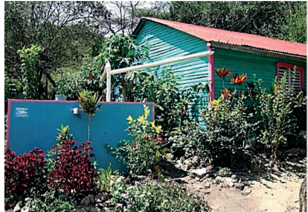
FIGURA 5. Captación de agua de lluvia en techo Fuente: (Frost, 2011)
