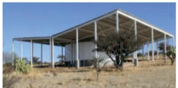
FIGURA 6. : Techo cuenca en la comunidad del Teongo, Aguascalientes. Fuente: Peraza-Gómez, 2011.
