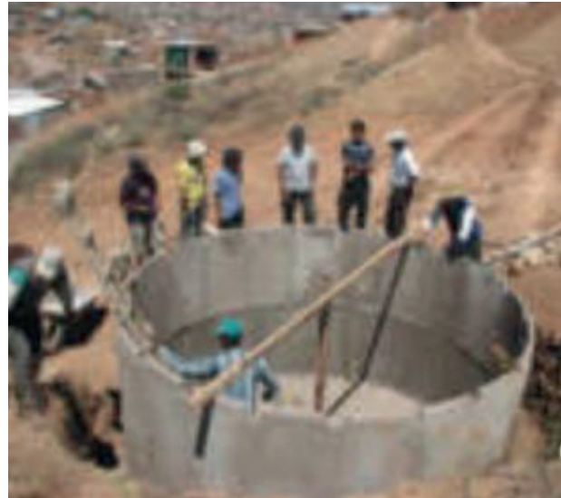
FIGURA 13. Cisterna concreto hecha en obra. Fuente: Aguel Dal Cil, 2010.
