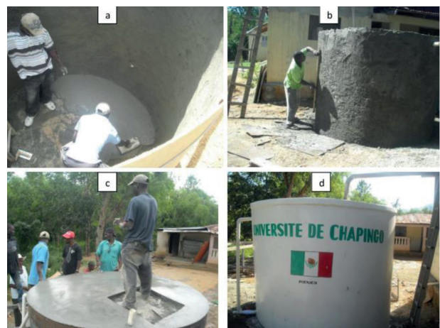
FIGURA 14. Fabricación de cisterna de ferrocemento. Fuente: Pedroza et al. , 2014.
