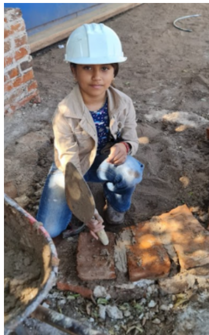
Figura 9 Estudiantes en la co-construcción del SCCALL, aportando saberes locales y habilidades técnicas en la instalación de canaletas
