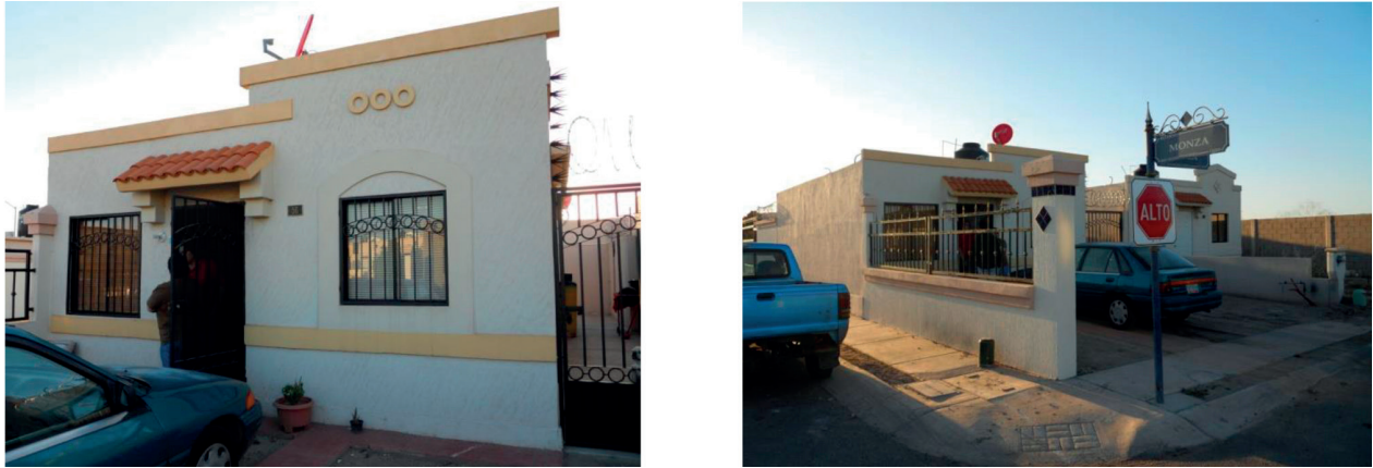
FIGURA 5. Vistas de las fachadas de la vivienda evaluada (Fuente: Archivo propio).
