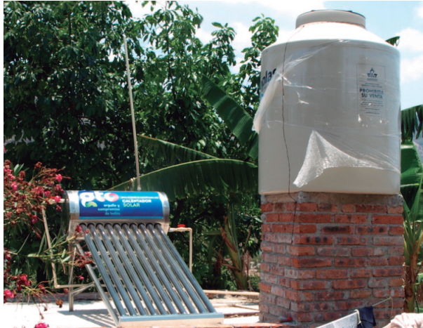
FIGURA 1. Fotografía de un calentador solar de agua en el municipio de Pénjamo, Guanajuato.
