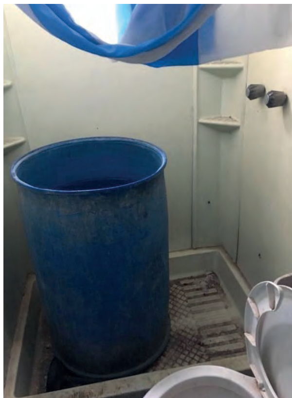
FIGURA 4 Baño de una casa en Silos
